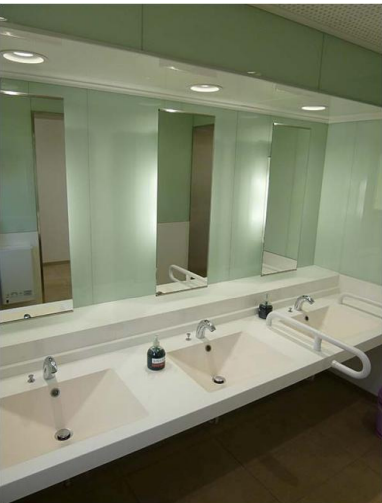
竹崎グランドトイレ 女性トイレ 洗面コーナー
