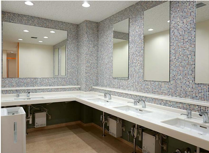
材料実験開発棟 女性トイレ 洗面コーナー
