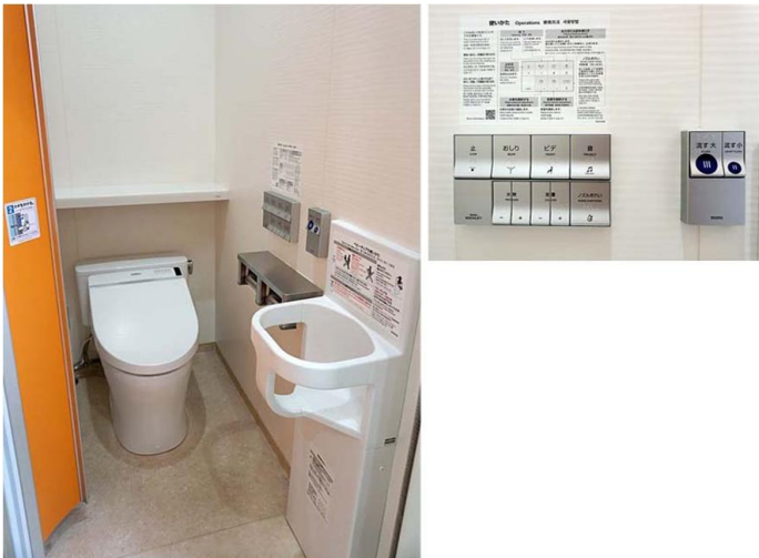
材料実験開発棟 女性トイレ 大便器ブース
