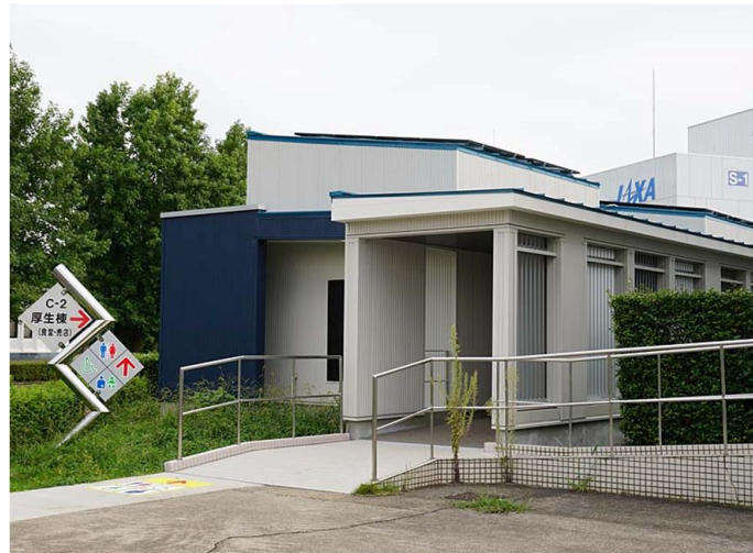
厚生棟 トイレ外観
