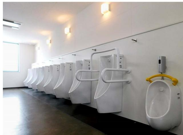
小便器は清掃性のよい壁掛式自動洗浄小便器を採用。足元には光触媒機能による防汚・防臭効果のあるハイドロセラ・フロアを設置。荷物配慮として小便器間にフックを完備している。また、幼児用小便器を1ヶ所設置。
