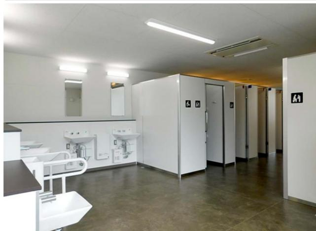
すっきり整えられたトイレ空間。床は長尺シートを採用し、清掃方式は乾式清掃としている。
