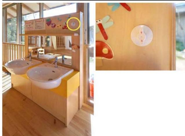
園児が使いやすい高さに設置した造作の洗面台には、手動水栓を選定。園児の手の届かない高さに元栓を設置して、使用時ごとに吐水の管理をしている。
