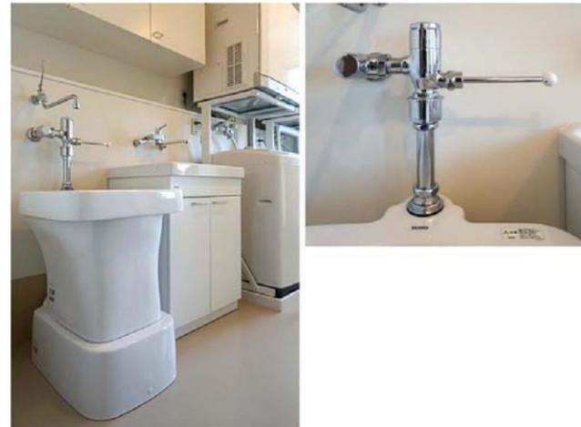
使い勝手や衛生面に配慮し、汚物流しはひじでも操作できるレバーの長いタイプを選定。また、汚物流しとの使い分けを徹底できるように、隣に洗濯流しユニットを設置している。
