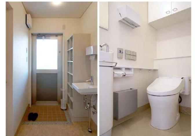
職員用玄関には、手洗器を設置。また玄関近くには、トイレと更衣室を配置している。職員トイレは、すっきりデザインで連続洗浄が可能なパブリックコンパクト便器・フラッシュタンク式を設置している。
