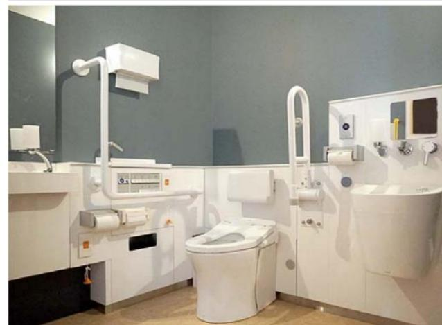
1ヶ所は、コンパクト多機能トイレバック(車いす・オストメイト対応セット)を選定し、オストメイト対応汚物流しを設置している。
