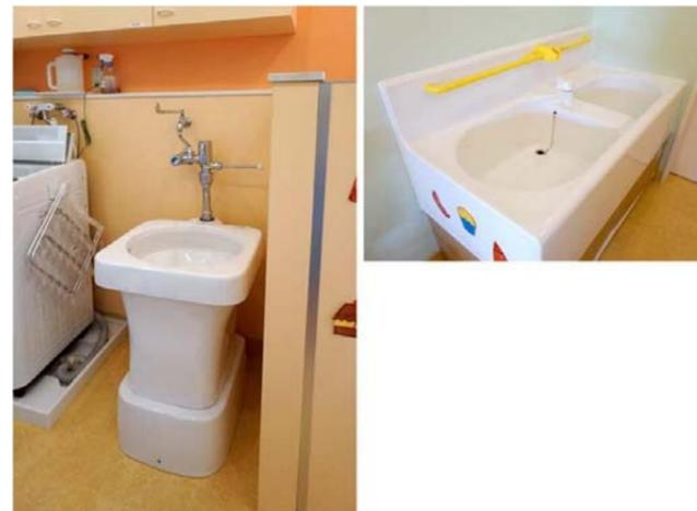
トイレ内の洗濯機横には、職員の作業動線に配慮し、汚物流しと2槽式の幼児用バスを設置している。
