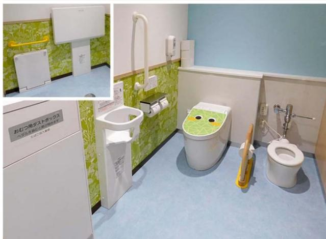
男性トイレにもひろびろブースを配置。隣接するベビーラウンジが混雑時におむつ替えができるよう、ベビーシート・おむつ用ダストボックスを設置している。
