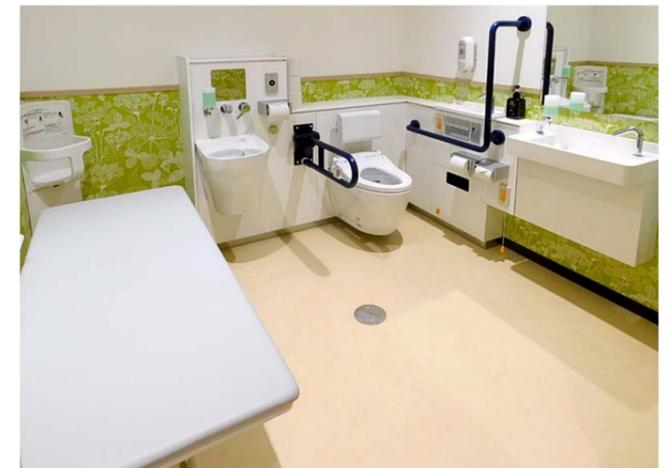
2400×2400mmと広く十分な空間を用意。必要な設備がパッケージされたコンパクト多機能トイレパックを採用し、大人用おむつ交換ができる多目的シートを完備している。
