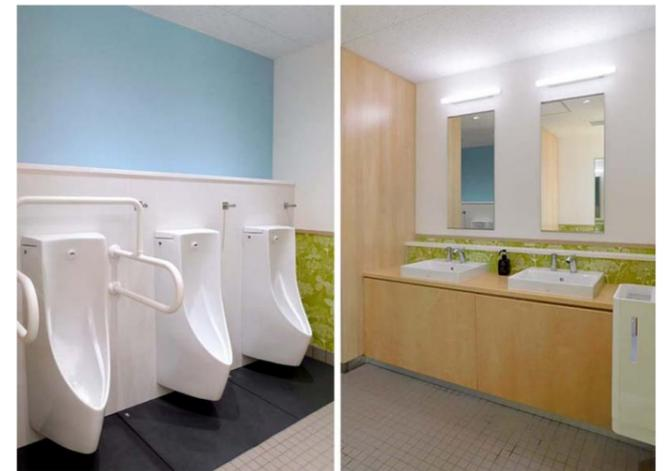
個別鏡と照明を設置した明るい洗面コーナー。小便器の足元には、尿の飛散によるにおいや汚れを軽減するハイドロセラフロアPUを設置している。
