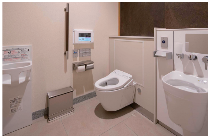
女性トイレ 大便器ブース (オストメイト配慮)
