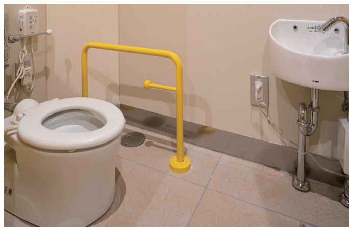
キッズトイレ 大便器ブース
