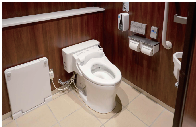
男性トイレ 大便器ブース
