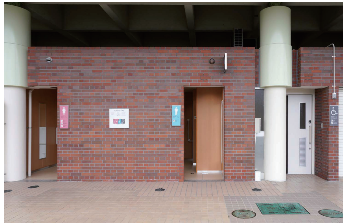
ゲート外 トイレ入口
