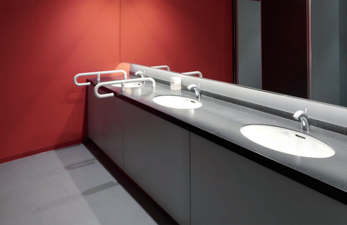
女性トイレ 洗面コーナー
