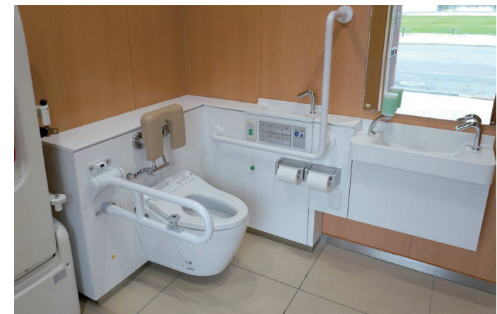
ゲート内 多目的トイレ
