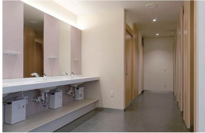
女性トイレ 全体
