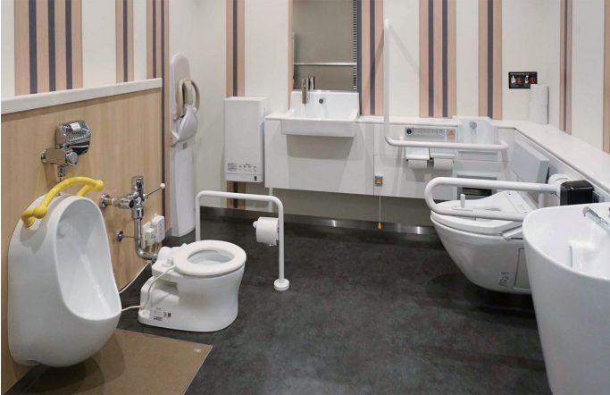
3F多目的トイレ
