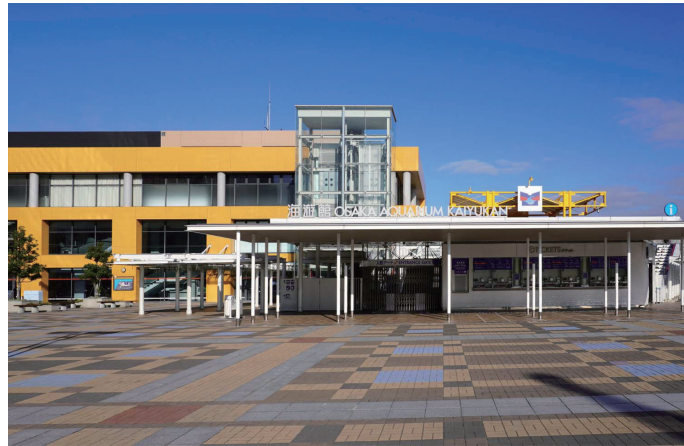
エントランスビル 外観
