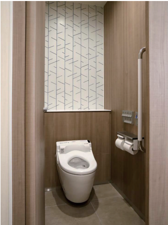
女性トイレ 大便器ブース
