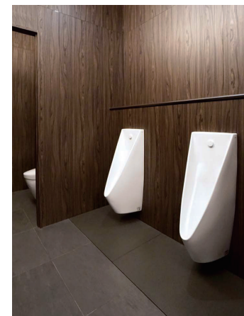
来客用 男性トイレ 小便器コーナー・ 大便器ブース
