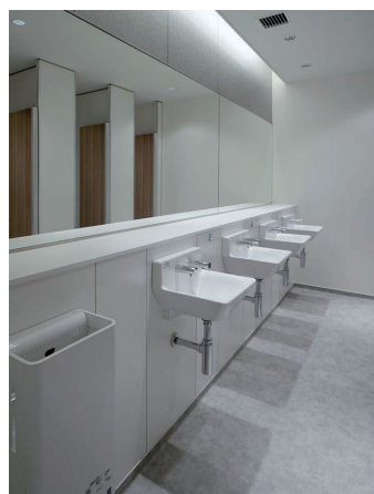
4F女性トイレ 洗面コーナー
