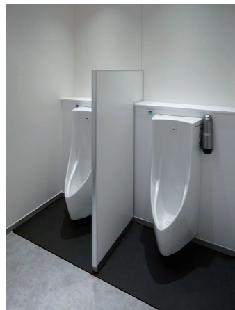
7F男性トイレ 小便器・大便器コーナー
