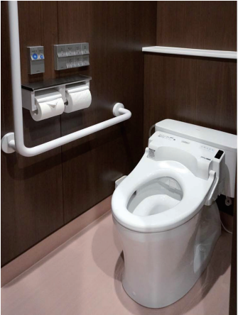
1F女性トイレ 大便器ブース
