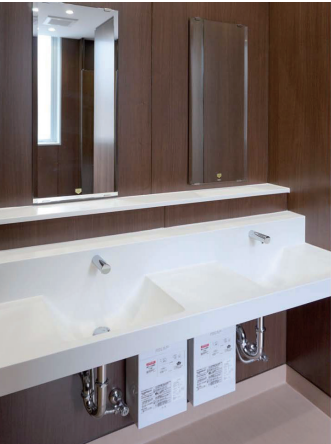
基準階女性トイレ 洗面コーナー
