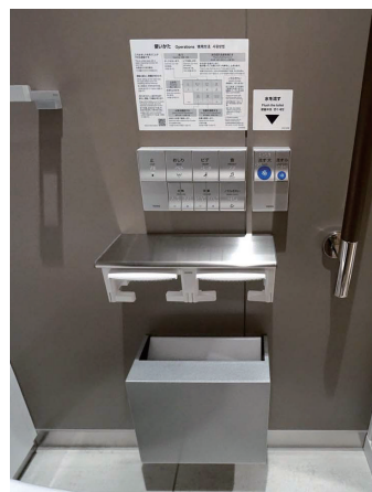
女性トイレ 大便器ブース
