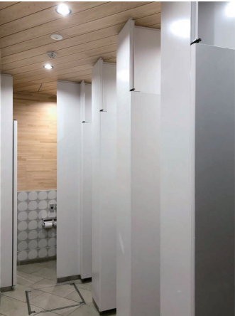
女性トイレ 大便器コーナー
