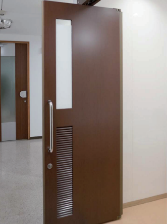
多機能トイレ 入口
