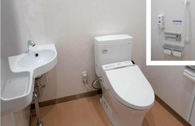
だれでもトイレ①
