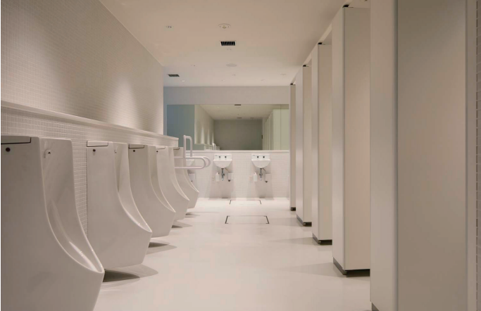
男性トイレ 全体
