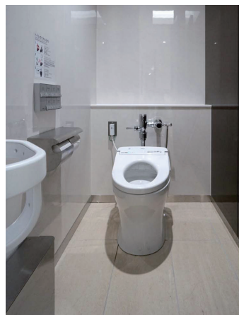
男性トイレ 大便器ブース
