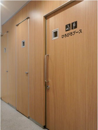
女性トイレ 大便器ブース
