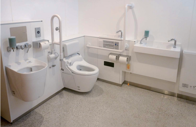
女性トイレ だれでもトイレ
