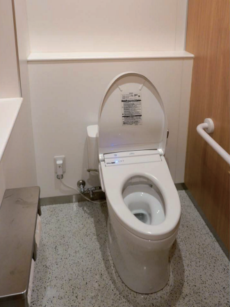
女性トイレ 大便器ブース
