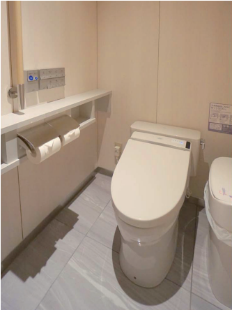
女性トイレ 大便器ブース
