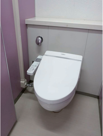
女子トイレ 大便器ブース
