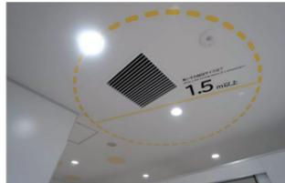
洗面コーナーは、車いすの転回を考慮して余裕のある広さを確保。天井には、車いすでの転回に必要な寸法(直径1.5m以上)を掲示している。
