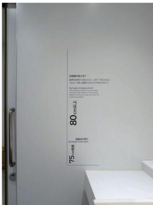
車いすが入りやすいカウンター式の洗面コーナー。洗面器は、前側のふち部分に両ひじが乗せられ、体が安定した状態で手洗いが可能。洗面台の高さを75cmとし、鏡は床面から80cmより上方へ100cm以上としている。
