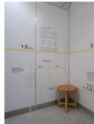
器具のカラーは温かみのあるアイボリー系を採用。大便器の基点(便座上面先)に赤い丸印をつけ、左右均等に35cmの位置に手すりを設けるようガイドするなど、充実した設備記載がなされている。
