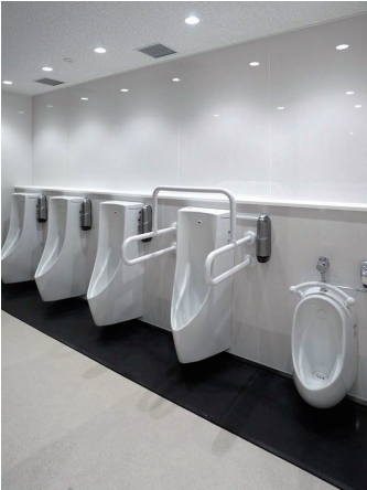
中ホール 男性トイレ 小便器コーナー
