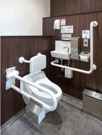
女性トイレ 大型ブース
