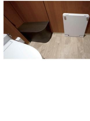
コンパクト設計にこだわり、連続洗浄可能なパブリックコンパクト便器・フラッシュタンク式を設置。学生の着替えの要望に応え、ブース内にはフィッティングボードや荷物置き台を設置。学生から好評を得ている。
