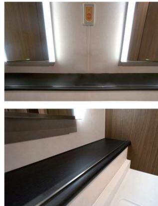
カウンターとボウルに継ぎ目がなく、清掃性に優れたボウル一体タイプのカウンターを設置。すべての洗面カウンター上部には、手荷物の落下やずれ落ち防止のバーを埋め込み造作している。
