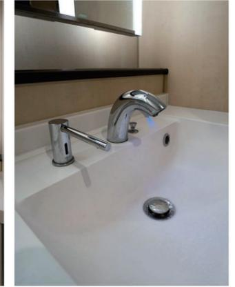
すっきりとした洗面コーナーには、カウンターとボウルに継ぎ目がなく、清掃性に優れたボウル一体形タイプのカウンターを採用。水栓は、「きれい除菌水」が搭載された自動水栓を設置している。
