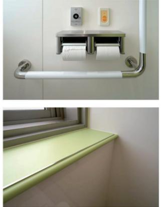
入口サインとあわせ同色のカウンターを設置。便器の洗浄は非接触にこだわってセンサー式を採用した。さらに全ブースに防犯対策として呼出ボタンを設置している。
