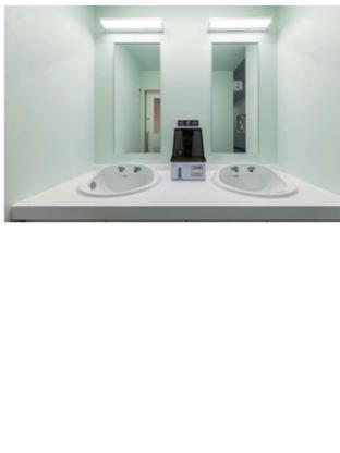
洗面コーナーは、準清浄区である廊下からトイレに入る緩衝区域となるよう設置。温風乾燥機能のついた自動洗面器オートボウルとアルコール消毒器を設置。すべて非接触で完結できる。靴で入室できるのはこの場所まで。
