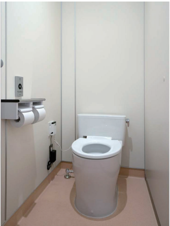
女子トイレ 大便器ブース
