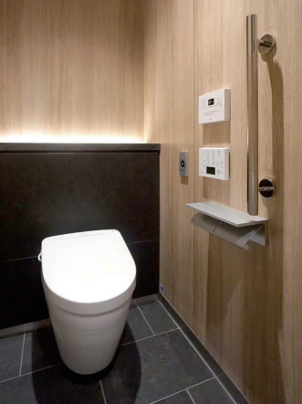
男性トイレ 非接触ブース
