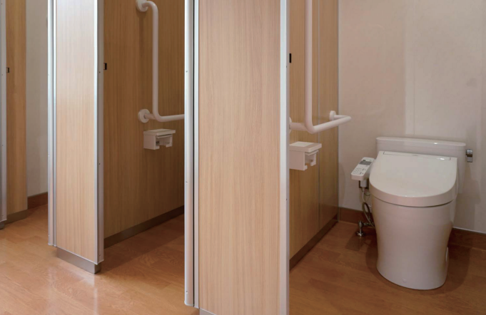
女子トイレ 大便器ブース
