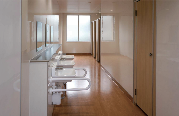
女子トイレ 全体
