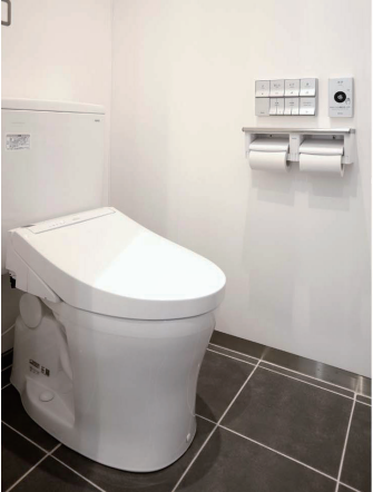
2F男性トイレ 大便器ブース
