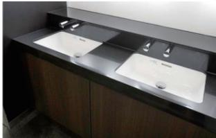
シックな内装にあわせ、洗面カウンターは豊富なカラーバリエーションから選べるツインデッキカウンター（陶器タイプ）を採用。衛生性に配慮し、非接触で手洗いができる自動水栓と自動水石けん供給栓を設置している。
