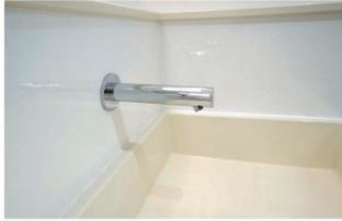
洗面コーナーの流し台には、既存の配管を生かして壁付自動水栓を設置。自動水栓は乾電池交換などのメンテナンス負荷軽減に配慮して、AC100Vタイプを採用している。
