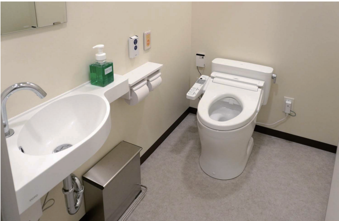
基準階トイレ 大便器ブース
