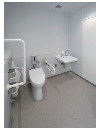
体育館トイレ
