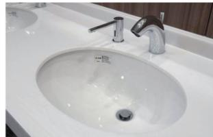
衛生配慮として、非接触で使用できる自動水栓とオートソープディスペンサーを採用。また、手荷物の配慮としてライニングを設置している。
