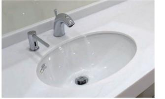
衛生配慮として、非接触で使用できる自動水栓とオートソープディスペンサーを採用。生徒からは「簡単に洗える」「自動になり、触れなくてもよくなったので安心」と声が上がっている。
