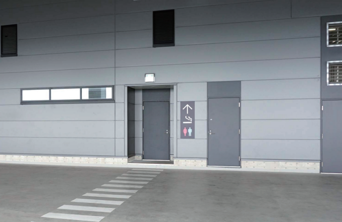
物流棟 中央コア トイレ入口
