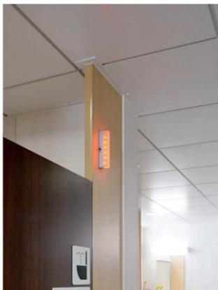
大便器ブースの扉の開け閉めと連動する表示ランプを設置。使用中は赤色、空室は青色のランプが点灯。また、洗面コーナーに設置されたモニターにも満空状況が表示される仕組みになっている。
