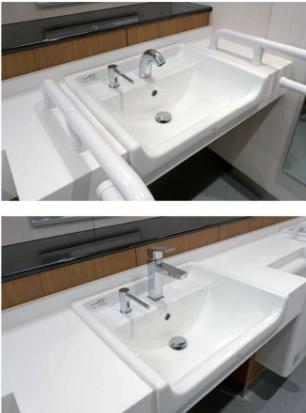
洗面器は、手洗い位置がカウンター面より低く、水はねを低減するセルフリミング式を採用。車いす使用者もアプローチしやすいよう足元に空間を設けている。水栓金具は自動水栓と、停電時を考慮した手動水栓を併設。
