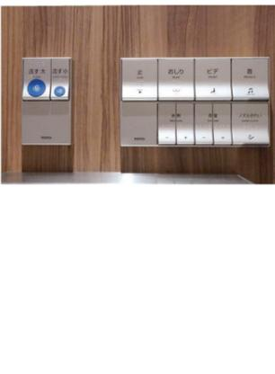
改修前は和式便器も設置されていたが、意匠性や維持管理の面からパブリックコンパクト便器・フラッシュタンク式を採用。リモコンは、電源工事や電池交換が不要な発電式のエコリモコンを採用している。
