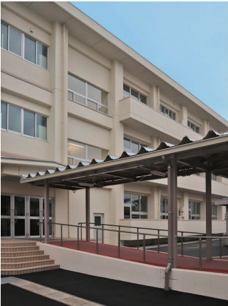
増築棟 1Fバリアフリートイレ
