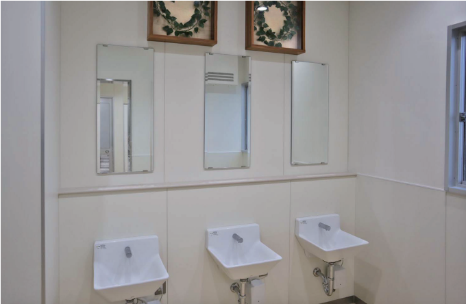
南校舎 男子トイレ 洗面コーナー
