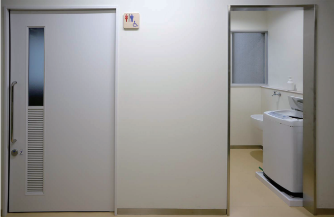
南校舎 バリアフリートイレ入口
