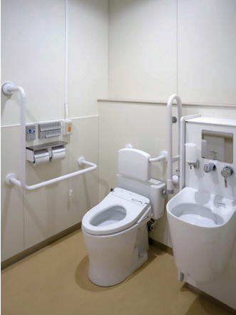
南校舎 バリアフリートイレ
