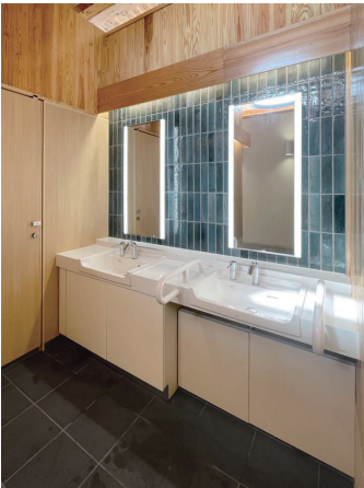
男性トイレ 洗面・小便器コーナー
