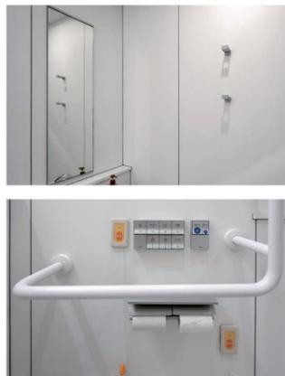
バリアフリートイレの操作ボタンは、ボタンを押すたびに発電し、乾電池や電源工事が不要なエコリモンを採用。棚に置ききれないバッグなどの荷物が配慮し、フックも上下2ヶ所用意している。
