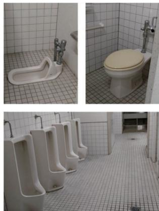
老朽化が見られた改修前のトイレは、タイル張りの内装で、一部に和式便器も設置されていた。さらに、手荷物配慮もなく、洗面コーナーには手動水栓が採用されていた。
