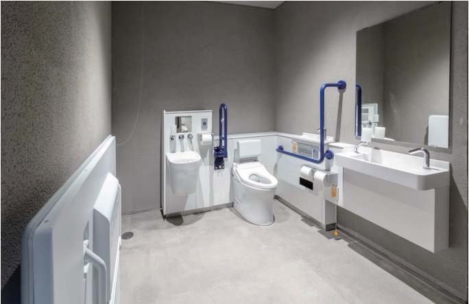
ファーム・プラントエリア バリアフリートイレ
