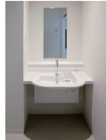
3F 4床室② 洗面コーナー・トイレ
