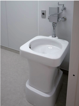
2F 透析室 汚物処理室
