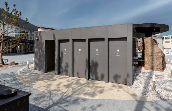
男性・オールジェンダートイレ全体
