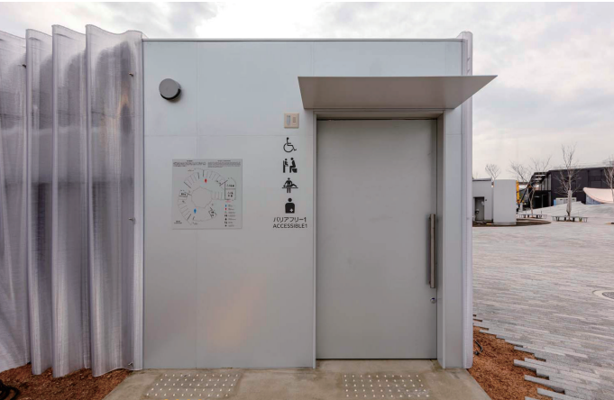
バリアフリートイレ 入口
