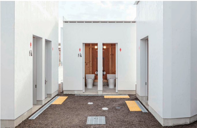
女性トイレ 全体
