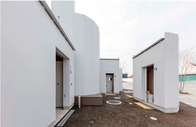
オールジェンダートイレ 全体
