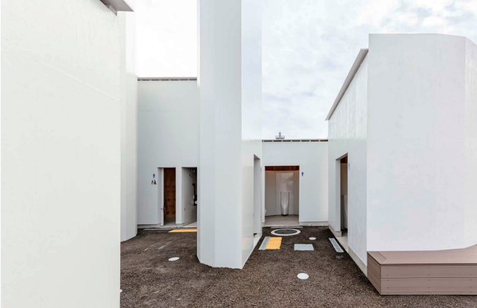
男性トイレ 全体
