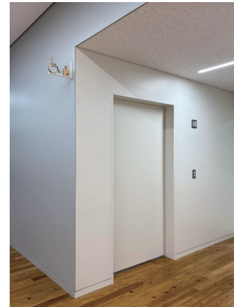
1F バリアフリートイレ 入口
