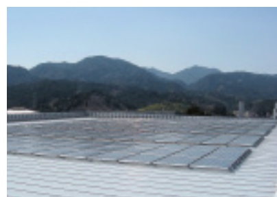
安装太阳能发电设备
