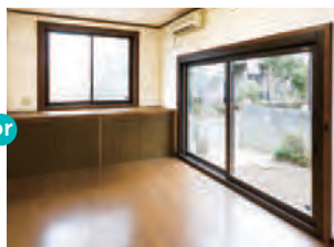
外窓交換:マドリモ 断熱窓
